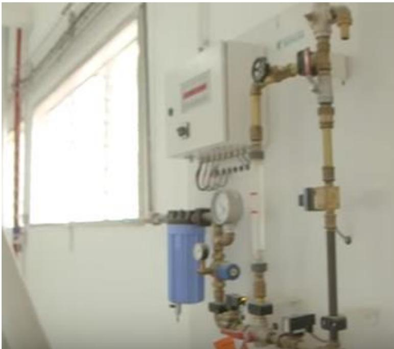
Circuit d'eau automatisé pour le nettoyage.
